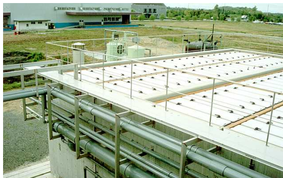
Beispiel UASB Reaktor für Pres. Franco Abwasserreinigungsanlage
